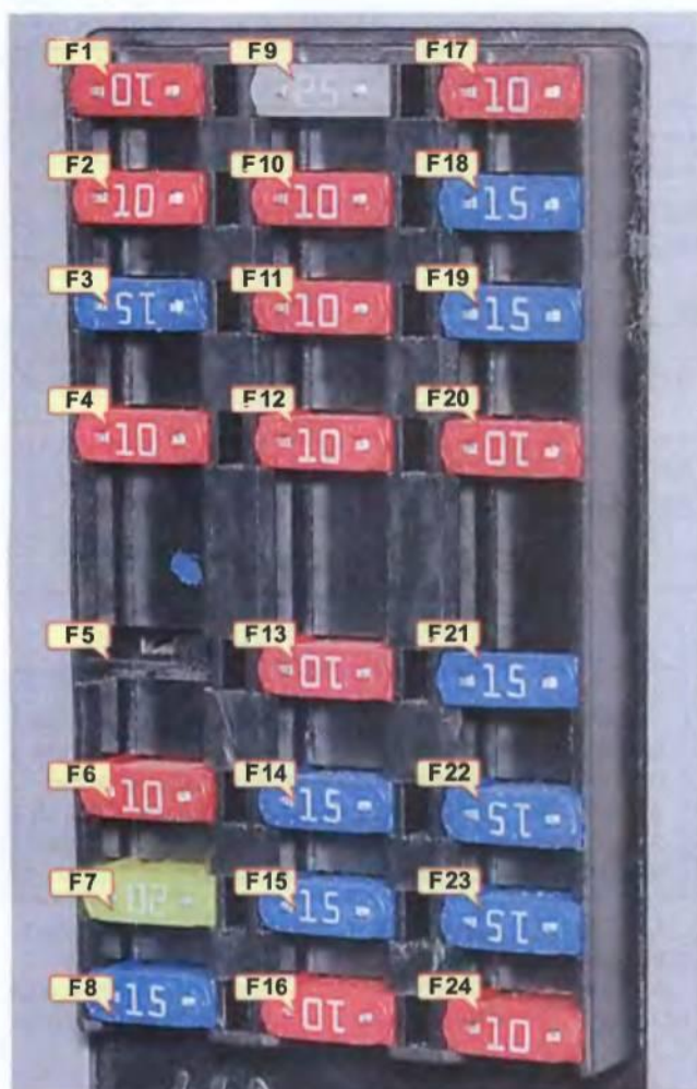
Монтажный блок предохранителей, расположенный в салоне
